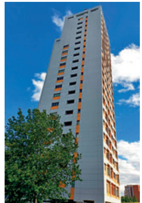
↑ No solo revestimientos seguros, los rociadores se han normalizado en muchos edificios de viviendas
