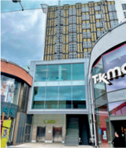
↑ Los trabajos de reforma prosiguen en menor medida en edificios de menos de 11 metros de altura
