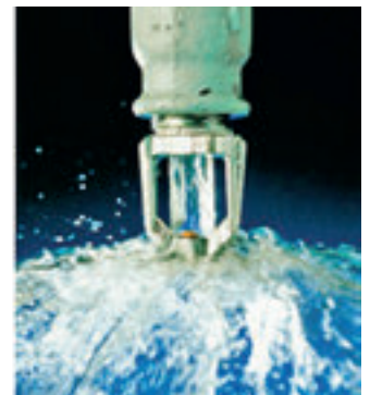
↑ La pulverización de un rociador se caracteriza por ser muy rápida y estar basada en la nebulización para penetrar mejor en el incendio
